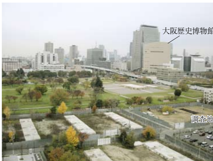
南東から見た調査地と難波宮跡公園
